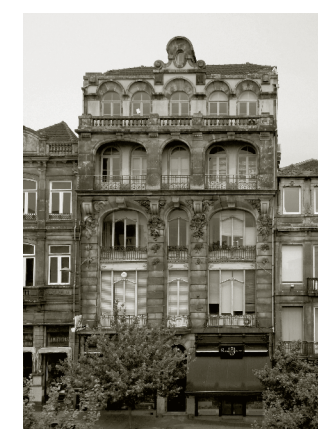
7. Edifício das Quatro Estações 1905, Rua das Carmelitas, 100
